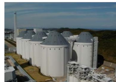
船で運ばれた石炭をためておくところだよ。1基に7万tの石炭が入るよ。全部で12個あるよ。
