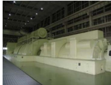
ボイラで作った蒸気でタービンを回すとタービンにつながっている発電機が電気を作るよ。
